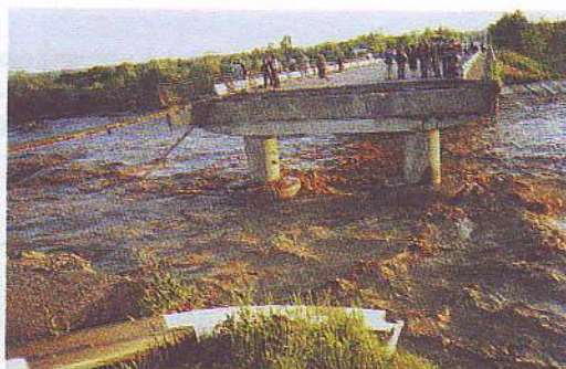
Разрушенные мост и дорога в результате ливневых дождей в Ставропольском крае
